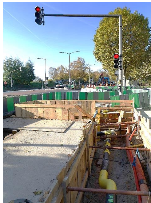
Vue d'une canalisation DN 400 à l'occasion d'un chantier.
